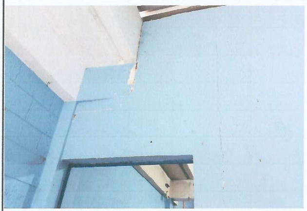
Foto 2: Mejoramiento dintel en la puerta de la cocina.
