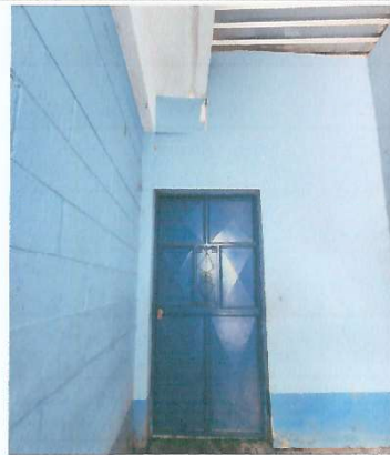
Foto 4: Sustitución de puerta de cocina.
