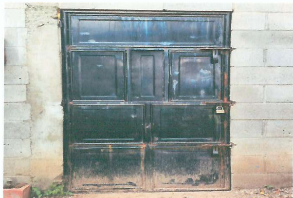
Foto 5: Sustitución de puerta salida de emergencia.
